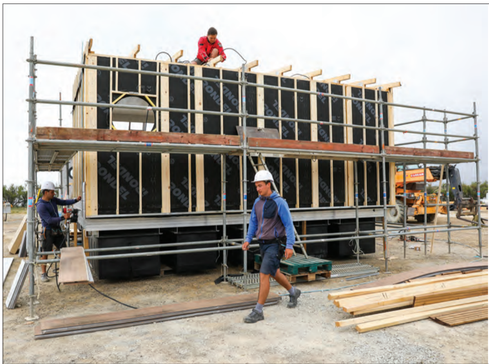
Chaque îlot a été conçu par l'entreprise Chalets Fabre, en Aveyron, et assemblé sur place. Une semaine est nécessaire pour la construction de A à Z : montage de la structure, des cloisons, des cuisines, des salles de bain et électricité.
