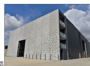
Poste source de Balma-Gramont.
