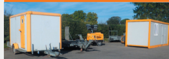
Bungalow, abris de chantier, mât d'éclairage, 16 remorques, cuves, tranches, BRH, foreuses, tarrières etc....
